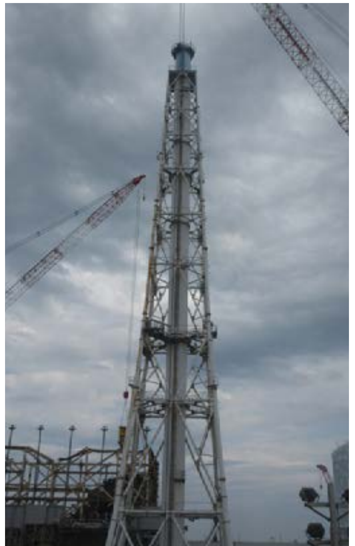
エイブルが切断に取り組んでいる、1、2号機の排気筒
