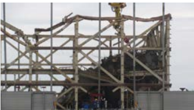
水素爆発で建屋の上半分が吹き飛んだ4号機
